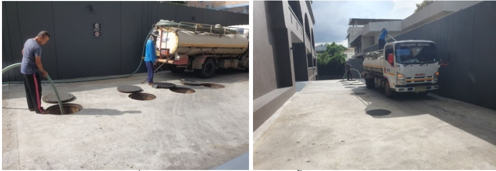
ภาพที่ 6-9 ดูตะกอนส่วนเกินระบบบำบัดน้ำเสียและส่วนเกรอะ
