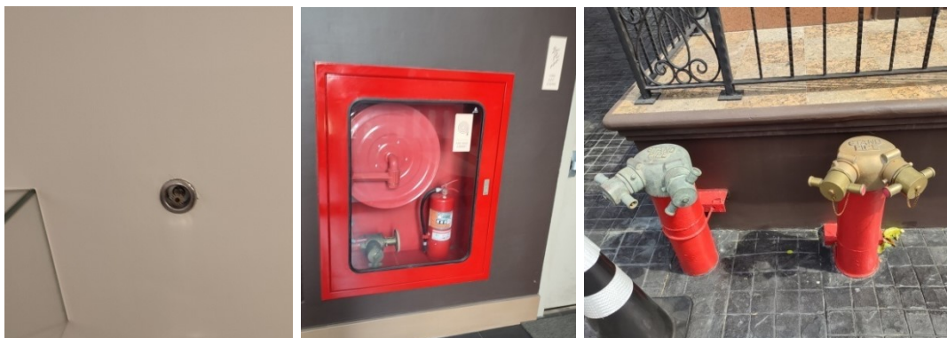
ภาพที่ 6-18 อุปกรณ์ดับเพลิง หัวกระจายน้ำดับเพลิงอัตโนมัติ ตู้เก็บสายฉีดดับเพลิง และหัวรับน้ำดับเพลิงภายนอก
