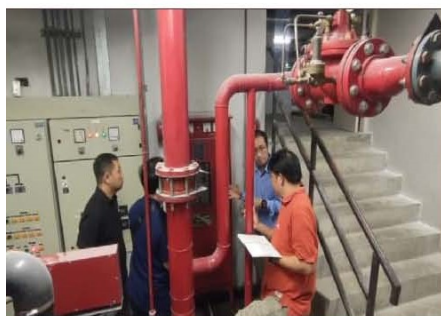
ภาพที่ 6-27 ตรวจสอบระบบสูบน้ำดับเพลิง Fire Pump
